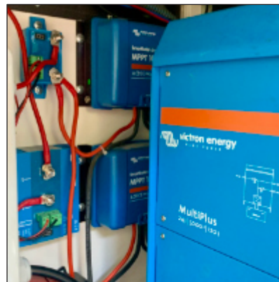
Victron Inverter, 2x Batterie 25,6V/200Ah, LiFe & Solar Controller
